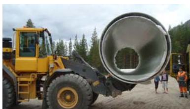
Skånsom løfting av rør
