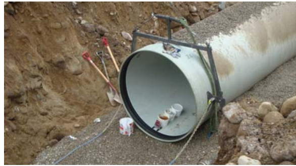
Klargjøring for neste rør
