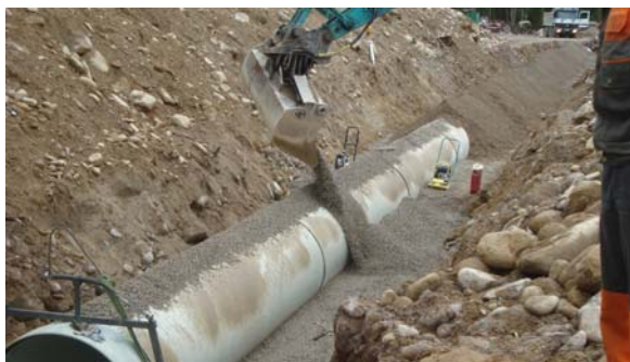
Forsiktig omfylling og komprimering
